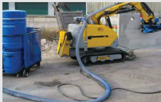
Rabotage / perçage avec système robotisé équipé d'une aspiration à la source THE
