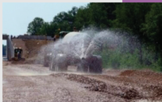
Arrosage des voies de circulation pour les chantiers BTP
