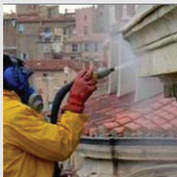
Décapage mécanique de parois en béton avec des billes de corindon, en remplacement du sable siliceux
