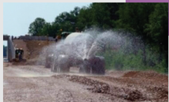
Arrosage des voies de circulation pour les chantiers TP
